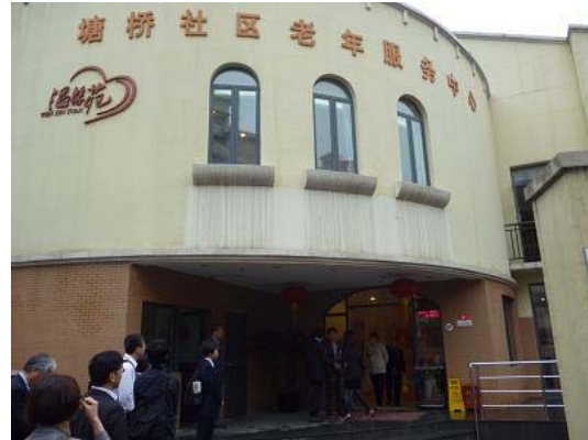
デイセンターの玄関 外観
