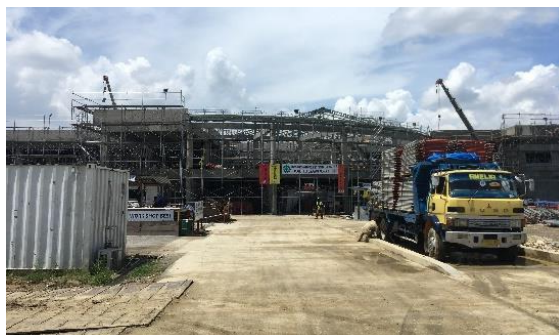
(建設中の校舎)
