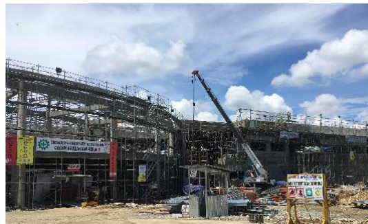
(建設中の校舎)
