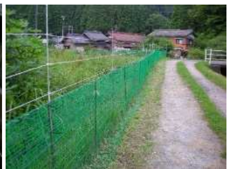
写真3 完成後の様子
