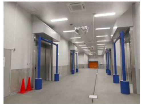
高機能物流棟内の様子
