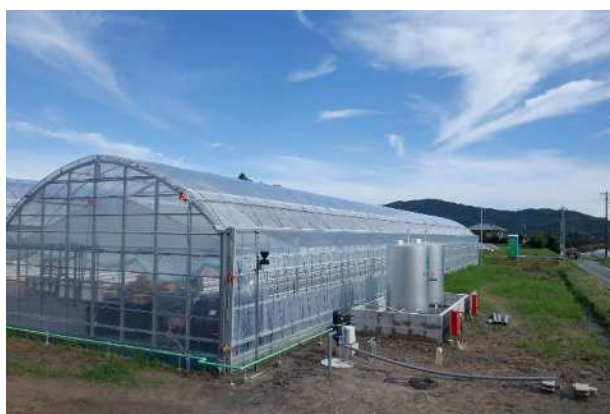
事業で整備した低コスト耐候性ハウス
