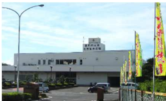
豊田市公設地方卸売市場
