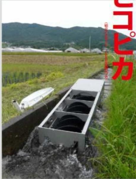
螺旋式ピコ水力発電機
