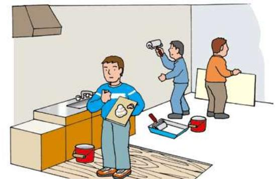
集合住宅の室内改装工事において、接着材に含まれていた有機溶剤の蒸気に引火爆発し、労働者3人が休業災害を負った。
