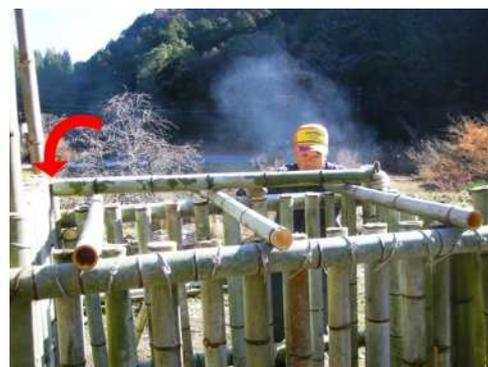
扉の動きとの干渉に注意し（矢印の部分）、縦材の長さを調節する
