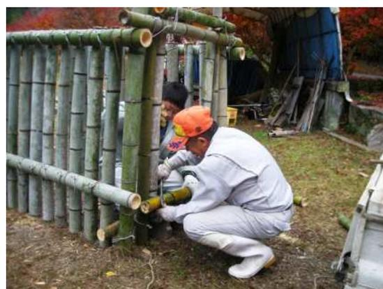
両端の縦材を組み付けて枠を作る。
