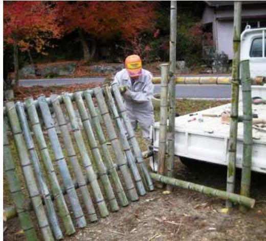
左右の壁を再び仮組みし、コの字状に組み上げる
