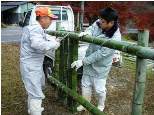
井桁を立てた状態で縦材を組み付けていく
