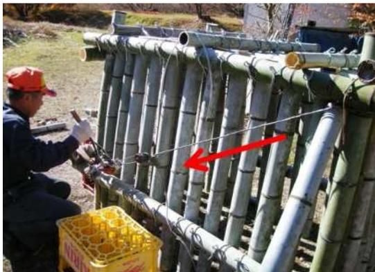
ウインチで矢印方向に引き、遠くから見て確認しながら形状を整える
