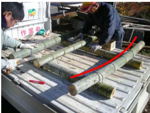
四隅の柱と横材の井桁を一旦取り外し、縦材の場所を決めていく
