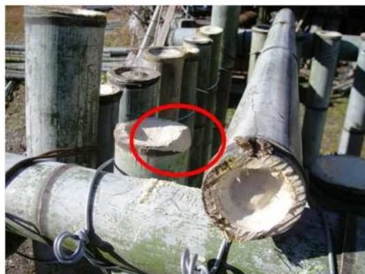
座りが悪い場合は、壁の縦材を削るなどして収まるように調整する
