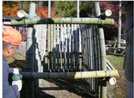
組み上げた状態で、四隅の柱に奥の壁の横材を本組みする
