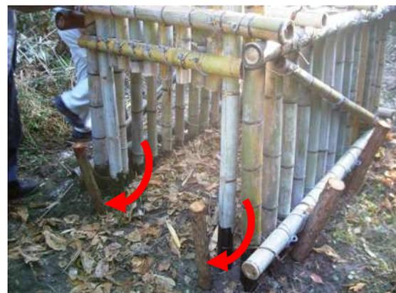
扉の両端に木杭を打ち、水平方向のストッパーとする
