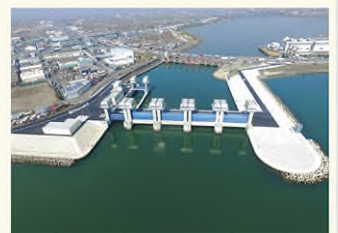
日光川流域の防災の要 日光川水閘門
