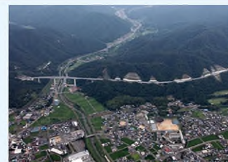
舞鶴若狭自動車道 敦賀衣掛大橋(福井県敦賀市)
