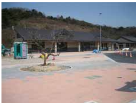
建設中の施設全景
