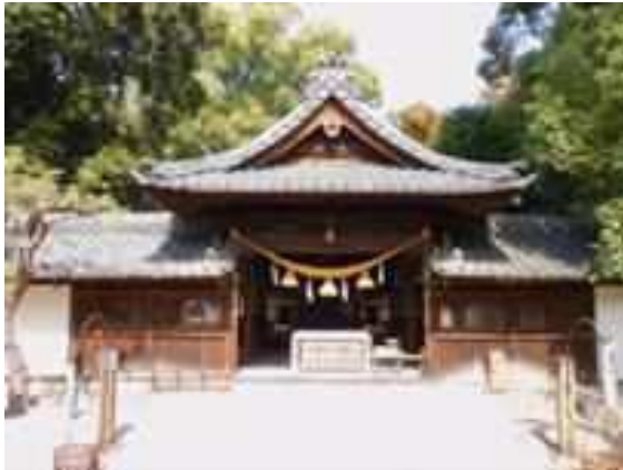
牛田八幡社中殿及び袖廊（知立市提供）
