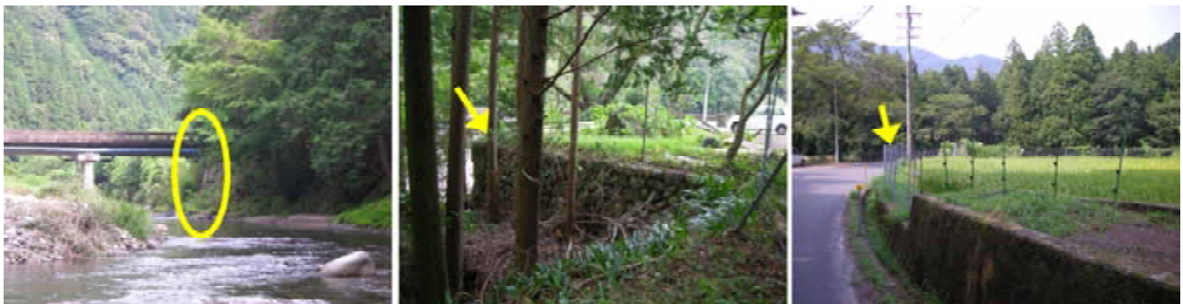
写真1 大規模柵開口部での設置の工夫（左及び中央：河川の護岸壁ギリギリまで設置する、右：農地沿いに袖状に延長）
