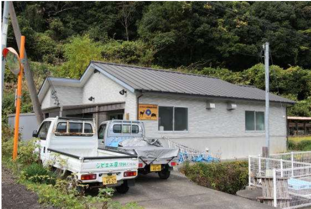
写真1 「ジビエ工房紀州」の解体施設
