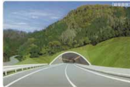
一般国道 257 号稲武拡幅(稲武町)
