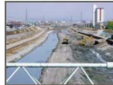
【新川河床掘削工事 (名古屋市)】
