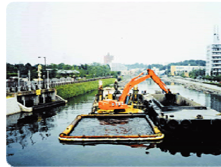
堀川の浚渫（名古屋市）
