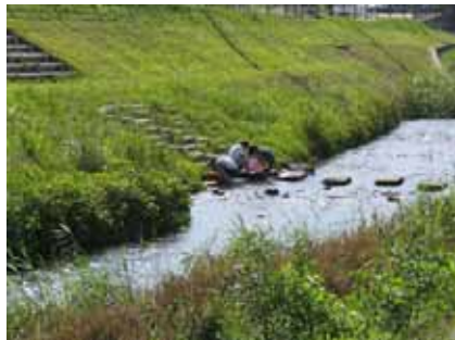
音羽川の多自然型川づくり（音羽町）
