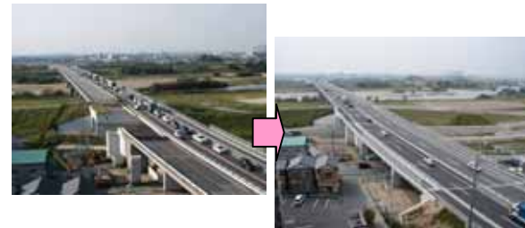
(主)岡崎刈谷線渡橋4車化(岡崎市)
