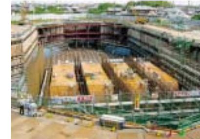
【日光川4号放水路工事 (一宮市)】
