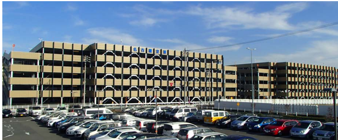
立体駐車場写真(平成26年12月10日撮影)
