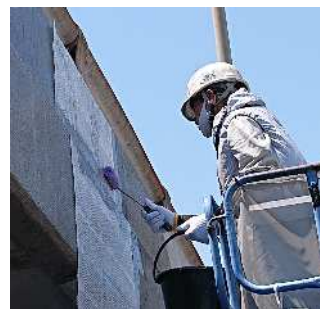
<剥落防止工施工状況>
