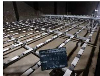
汚水処理に必要な空気を送り込む設備を省エネ型に更新
