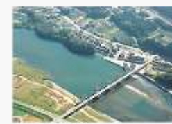
牟呂松原頭首工
