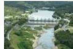
明治用水頭首工
