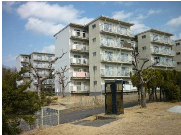
南東方より調査対象地
