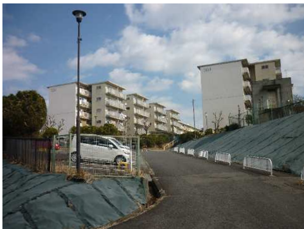
南方より調査対象地
