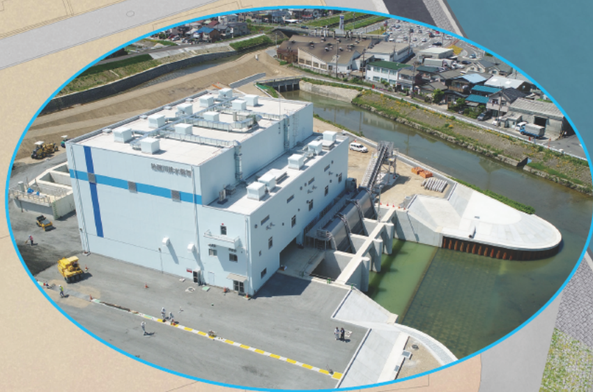
地蔵川排水機場全景写真(令和5年5月撮影)
