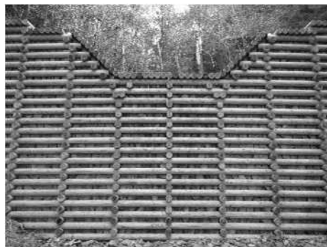
図-1 本試験で調査した溪間工（防腐処理木材のもの）
