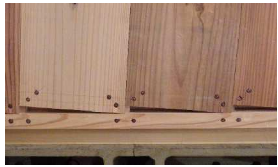
図-23 板のめり込み (試験体 7)
