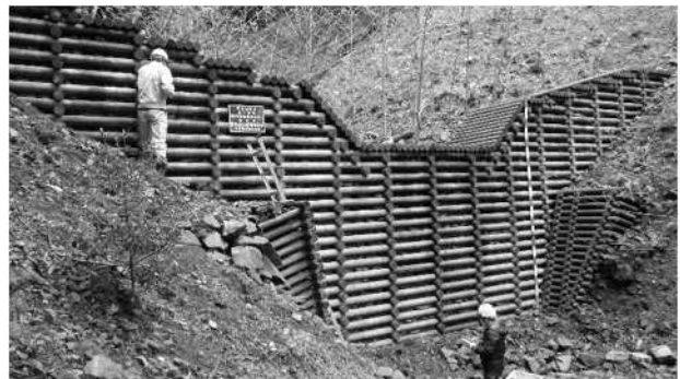
図-2 流水部と袖部および天端材と横木
