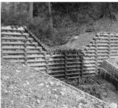
図-1 本試験で調査した溪間工（防腐処理木材のもの）
