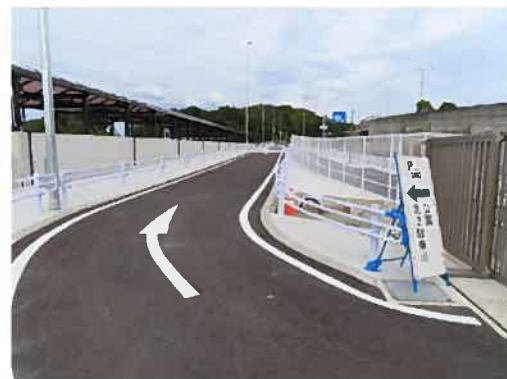
駐車場に入る場合は、入口通過後も駐車場に続く道が狭いので注意が必要です。
