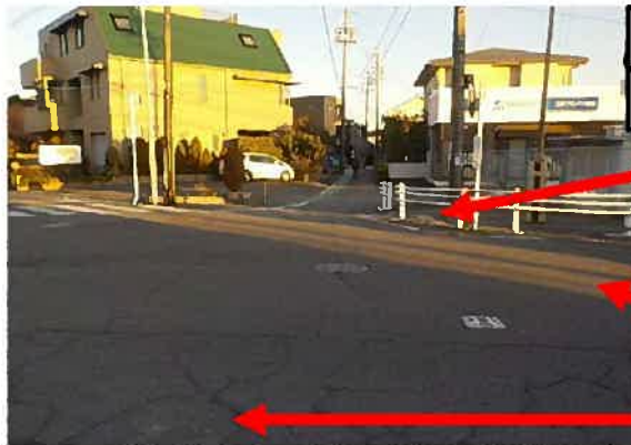
コーナー外側線の引き直し ポストコーンの設置
