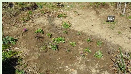
* 作業後の状況 *
