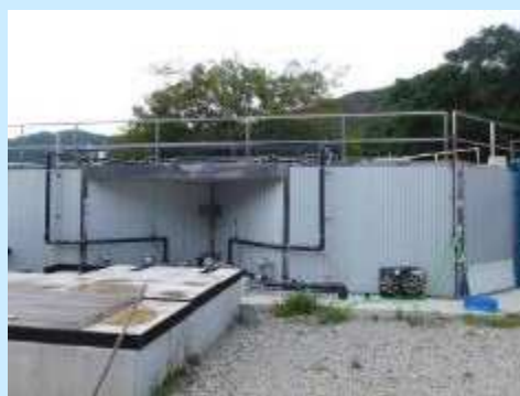
メタン発酵施設
