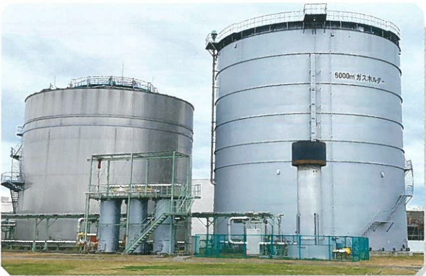
汚泥消化タンク
