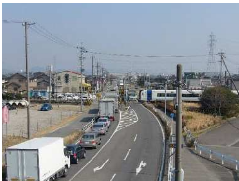
立体交差箇所の状況(一般国道155号)
