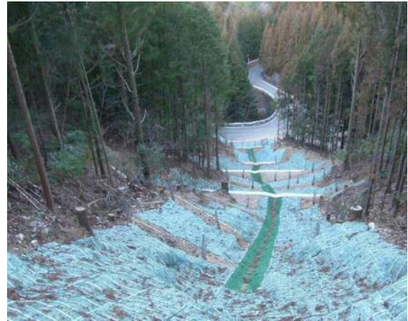
平成25年度山腹工施工地 （設楽町）
