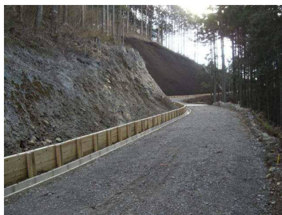
上新戸黒淵線の完了状況 (H25.12.24 新城市)
