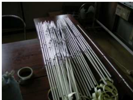
支柱(FRP絶縁ポール)の一部にアルミテープを巻く
