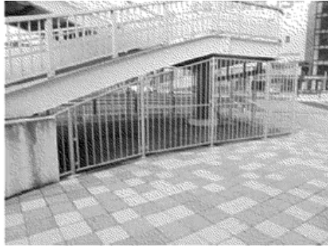
写真 3.5.8 立入防止柵設置事例（参考）
