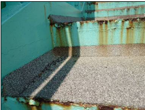
写真 3.5.9-1 舗装端部処理事例(階段部)
