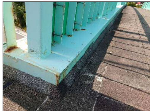
写真 3.5.9-2 舗装端部処理事例(通路部)
