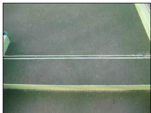
写真 3.5.9-11 接合部の補修事例
