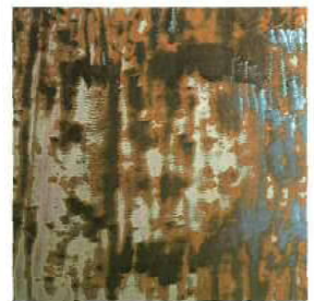
3種ケレン 動力工具と手工具を併用して劣化塗膜やさびを除去した程度。2種に近い状態。 (白い部分は金属光沢、青黒い部分は素地鉄の友、赤かつ色は下塗り塗膜、わずめ) 色は上塗り残存塗膜)
