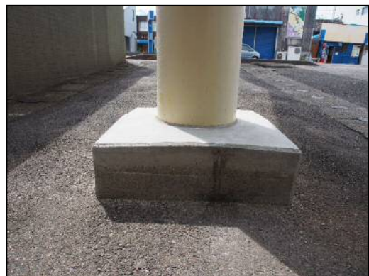
写真 3.5.9-7 橋脚基部の補修事例
