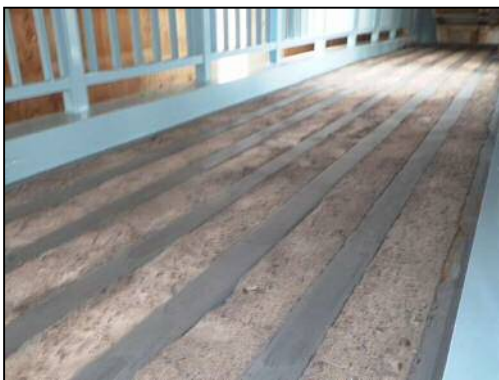
写真 3.5.9-5 既設舗装の撤去事例(参考)
