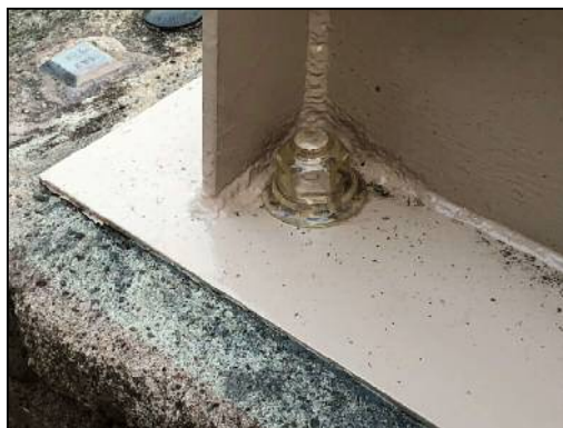
写真 3.5.7 保護キャップの設置事例(参考)
