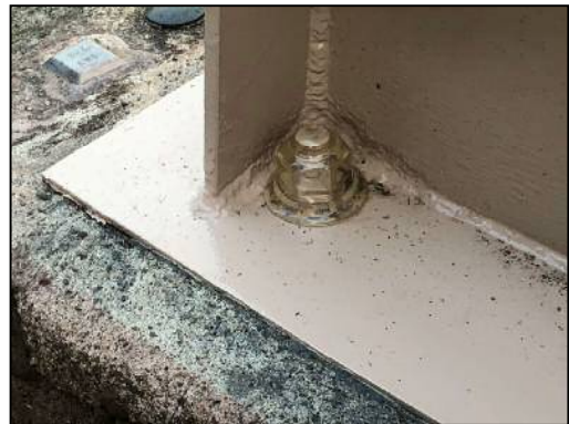
写真 3.5.9-9 アンカーボルトの補修事例
