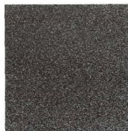
1種ケレン ショットブラスト工法により、さび、黒皮を完全に除去した程度。
