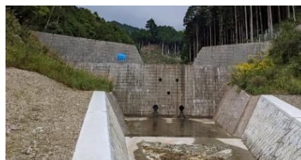
土砂災害防止施設（新城市）
