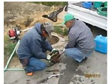
パイプライン空気弁の分解補修
