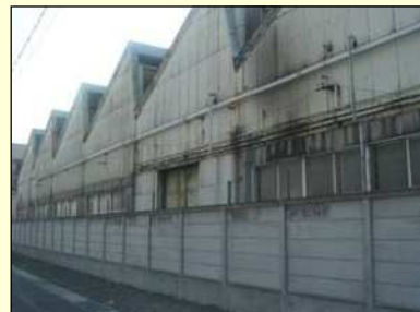
□工場の外壁、塀が、周囲に圧迫感を与えています。
