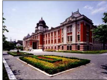
□市政資料館（名古屋市） 写真提供：名古屋市市政資料館
