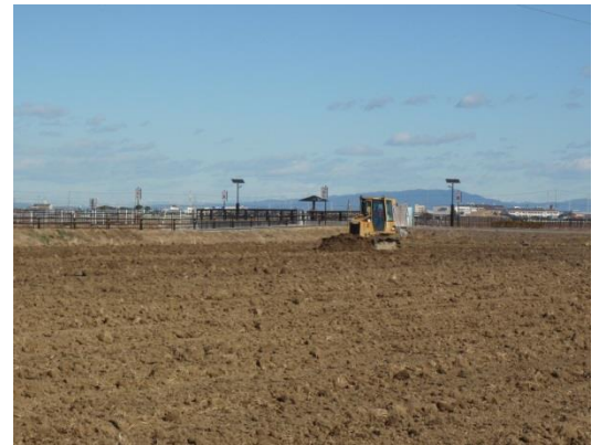
ほ場の整地状況（安城市 高棚地区）
