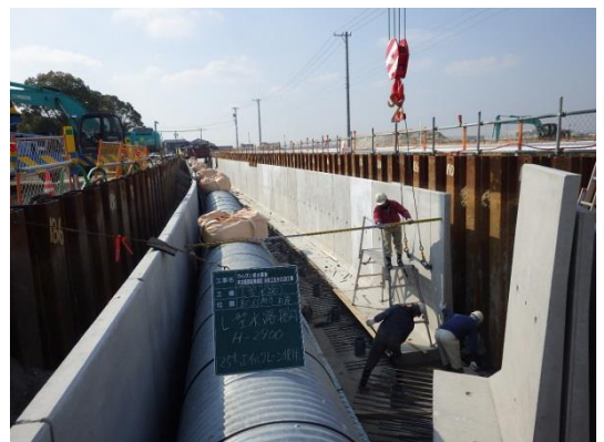
水路工事状況（刈谷市 中井筋依佐美地区）
