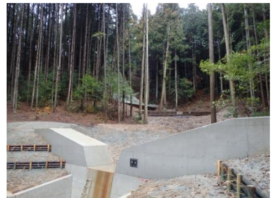
予防治山事業（谷止工と木製土留工）
