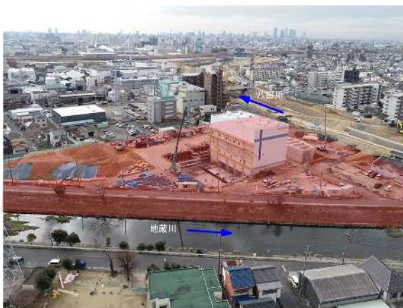
⑦地蔵川：排水機場の整備
