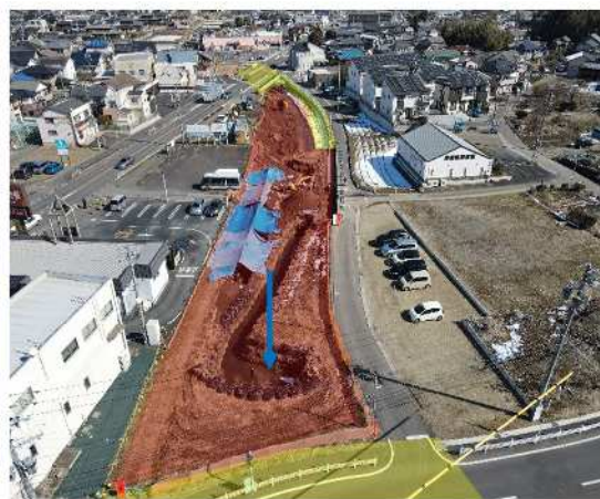
④青木川：町道 柏森高屋線橋梁改築
