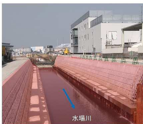
③水場川：河道整備（西流橋付近）
