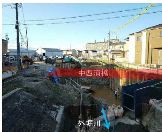
⑨外堀川：橋梁改築工事
