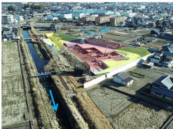
⑪青木川（第4調節池 築造工）
