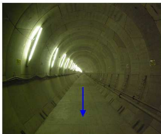
⑤青木川放水路函体工
