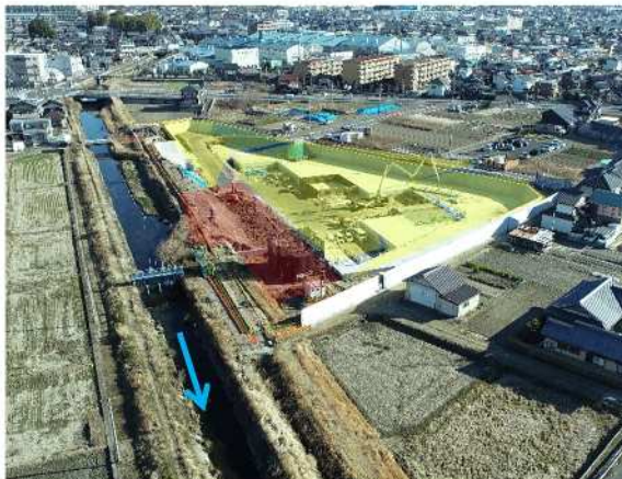
⑪青木川（第4調節池 築造工）
