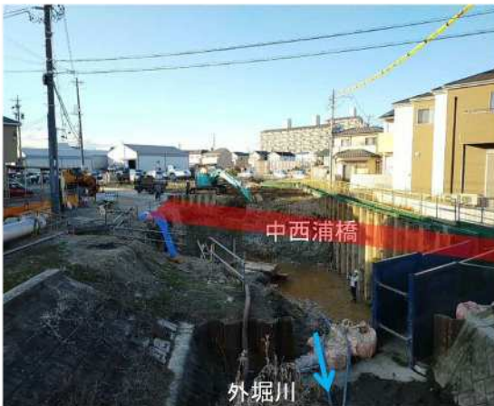
⑨外堀川：橋梁改築工事
