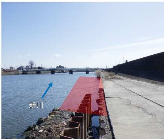
①新川：堤防の高潮対策工事
