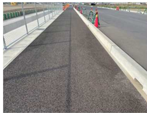
透水性舗装 (岩倉市)
