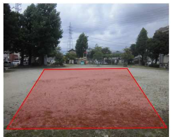
⑫小牧市（井領公園）：流域貯留施設
