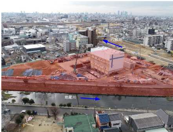
⑦地蔵川：排水機場の整備
