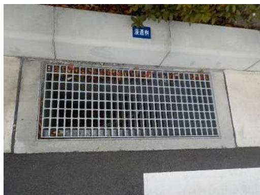
浸透柵 (名古屋市)
