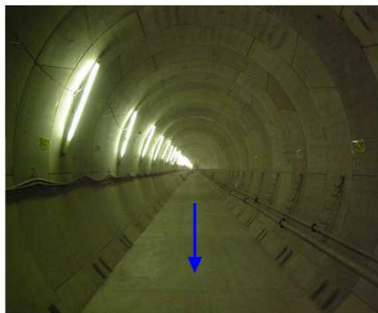
⑤青木川放水路函体工
