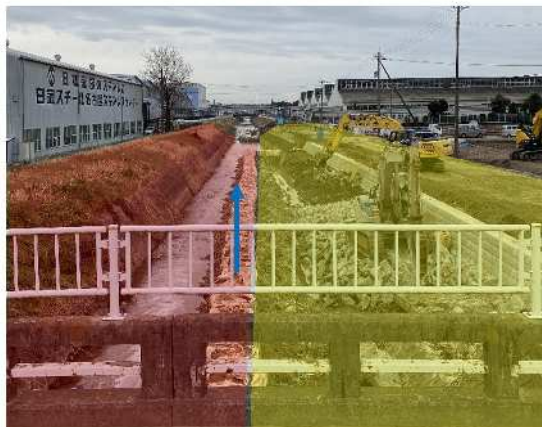
⑥合瀬川：用地補償及び河道整備
