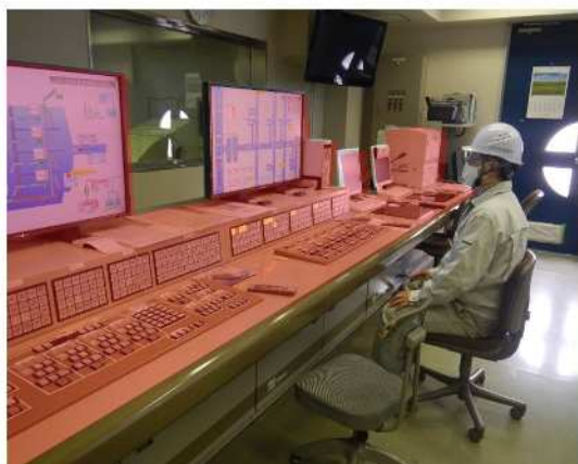
⑤青木川放水路電気・機械工事
