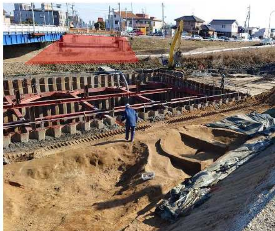
②五条川：清洲橋改築工事
