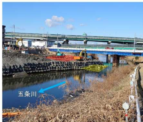
②五条川：清洲橋改築工事
