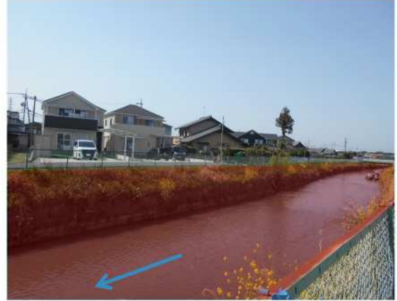
⑧薬師川：河道整備
