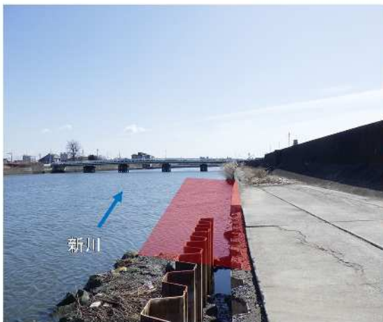
①新川：堤防の高潮対策工事
