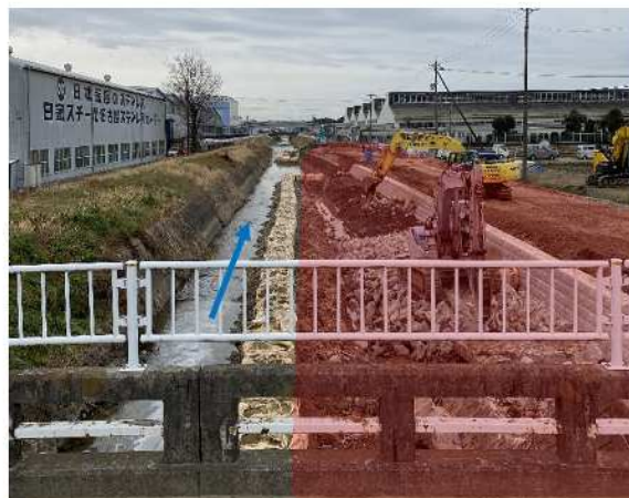
⑥合瀬川：用地補償及び河道整備
