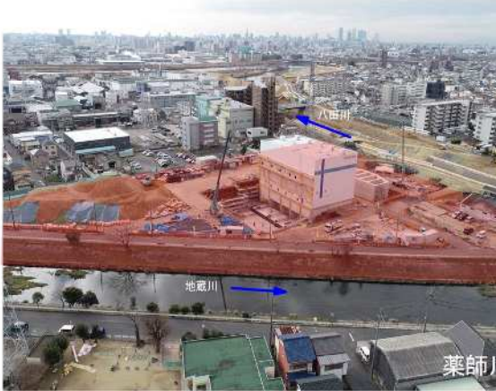
⑦地蔵川：排水機場の整備
