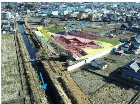
⑪青木川（第4調節池 築造工）
