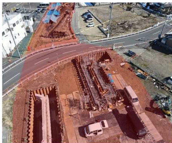
④青木川：町道 柏森高屋線橋梁改築工事
