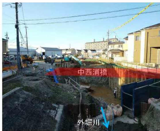
⑨外堀川：橋梁改築工事
