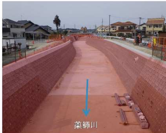
⑧薬師川：河道整備
