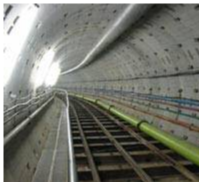
掘削完了状況（H16年3月） 道路の下にトンネルを掘り、大雨が降った時に一時的に雨水を貯めます。
