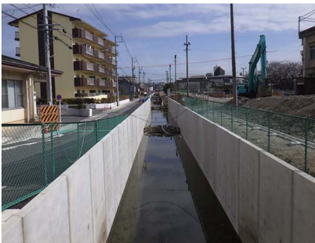
④原川：河道拡幅工事
