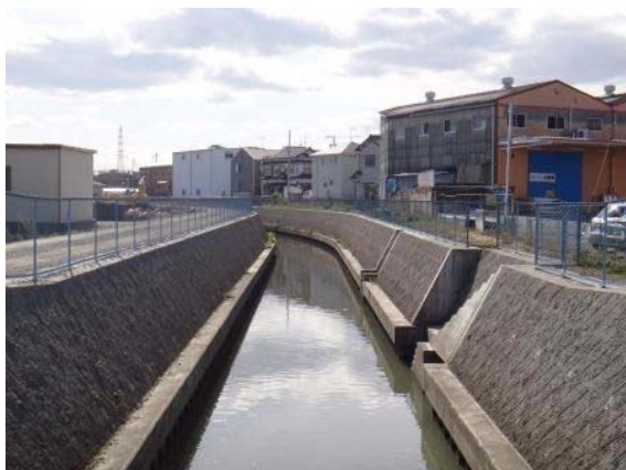
準用河川千間堀川改修（一宮市）
