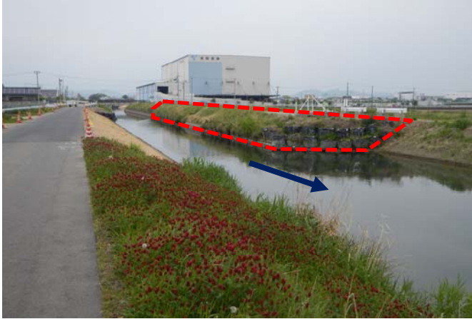
⑥合瀬川：護岸工事
