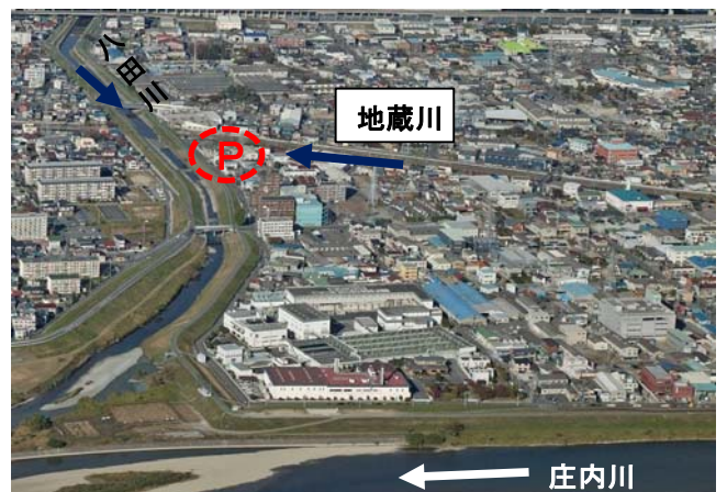
⑨地藏川：排水機場建設予定箇所
