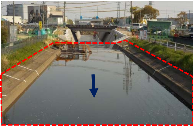
⑧薬師川：護岸工事
