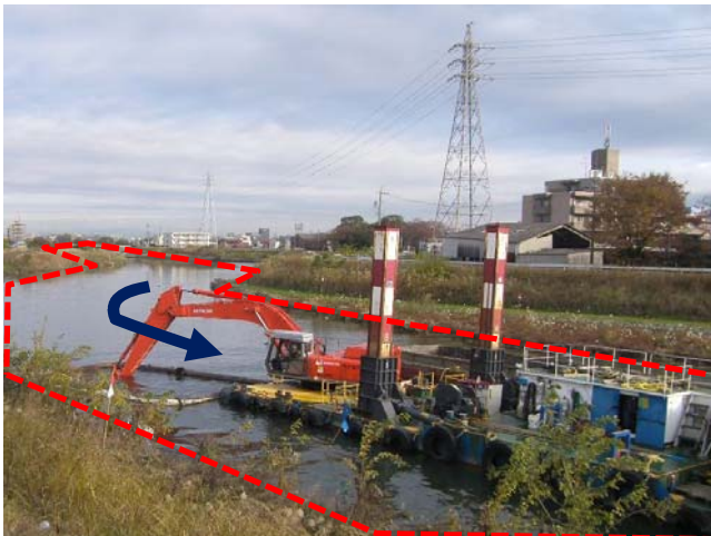
②五条川：浚渫工事の状況
