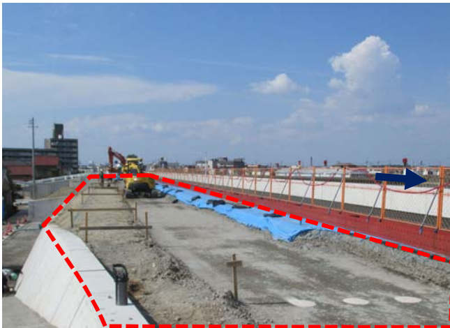
①-1新川：築堤・護岸工事の状況
