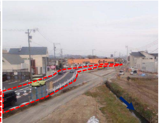
⑥青木川：県道一宮犬山線橋梁改築
