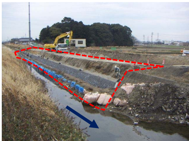
⑦合瀬川：護岸工事の状況
