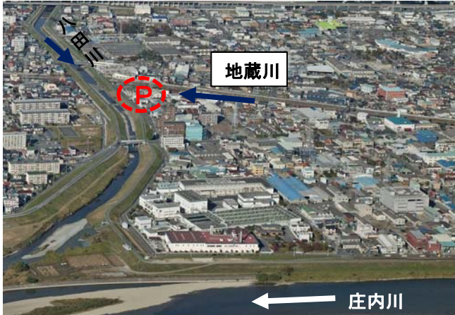
⑦地藏川：排水機場建設予定箇所
