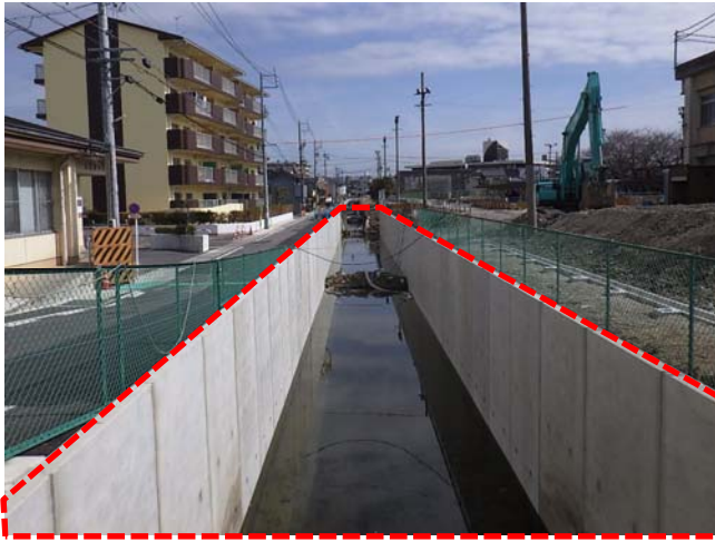
⑤原川：河道拡幅工事の状況
