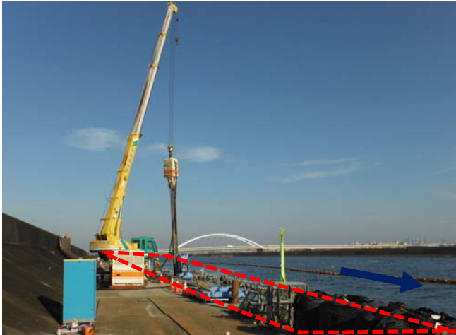
①新川：堤防耐震化工事
