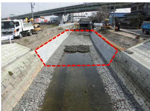
④-1中江川：河道拡幅工事の状況
