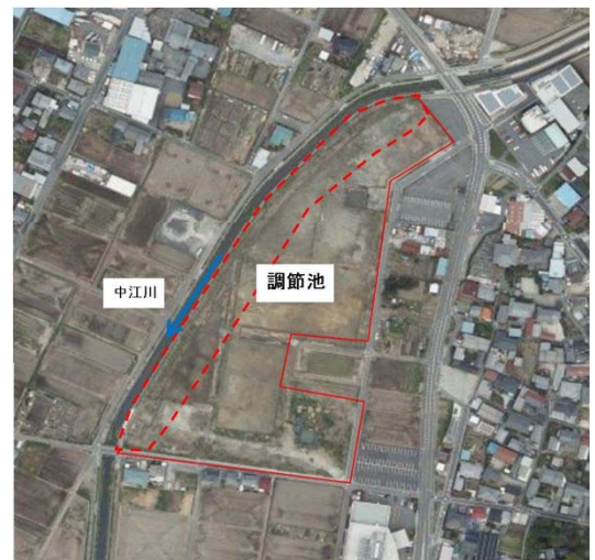
④-2中江川：調整池の掘削状況
