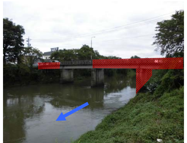
②-1五条川：船杓橋改築工事
