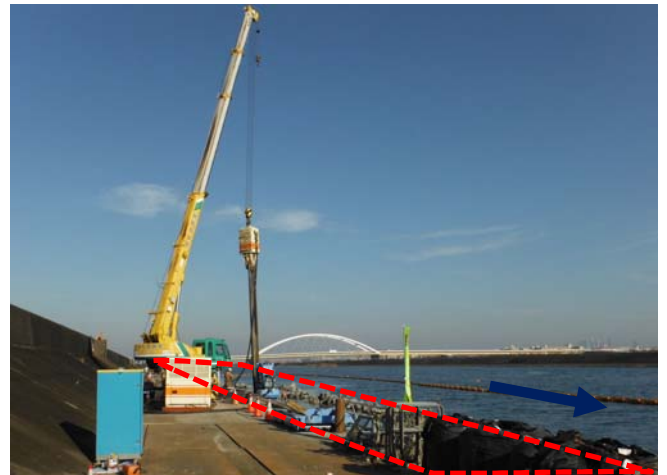
①-2新川：堤防耐震化工事の状況
