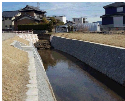
準用河川道木川改修（小牧市）
