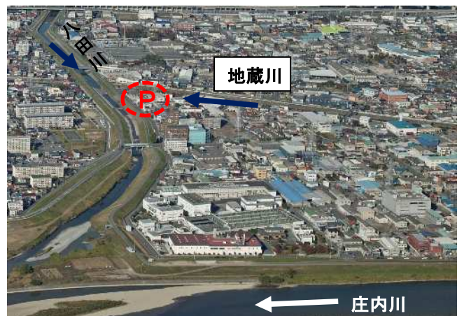
⑨地藏川：排水機場建設予定箇所
