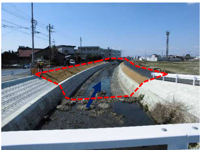
④中江川：河道拡幅工事箇所
