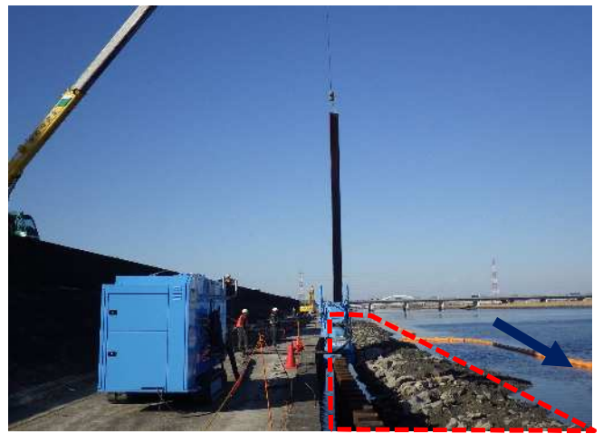
①-2新川：堤防耐震化工事の状況
