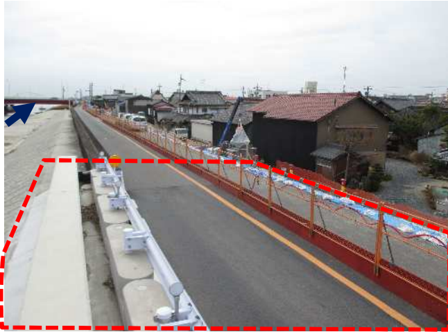
①-1新川：築堤・護岸工事の状況
