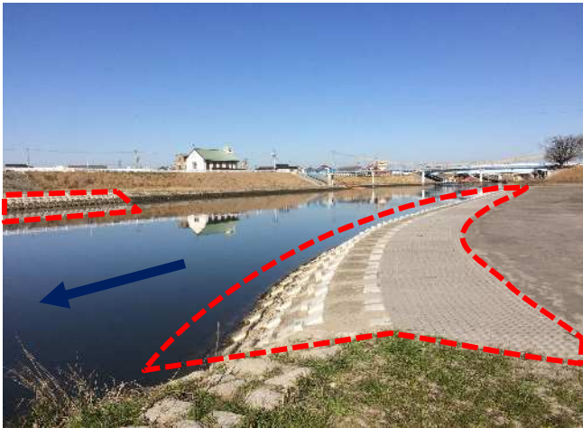
②五条川：護岸工事箇所
