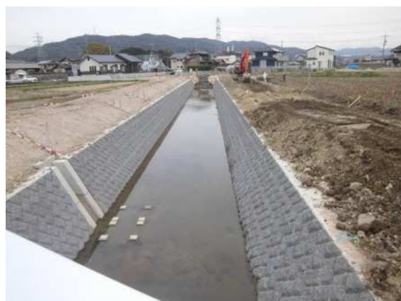
準用河天道木川改修(小牧市)
