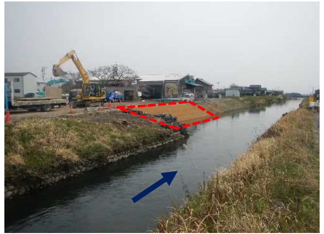
⑦合瀬川：護岸工事の状況
