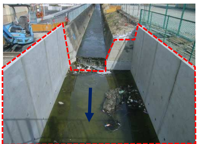
⑤原川：河道拡幅工事の状況
