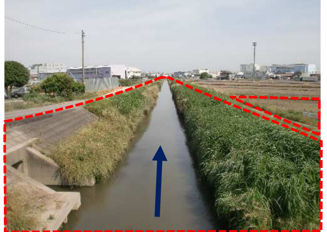
③水場川：今後の改修区間及び遊水地予定地
