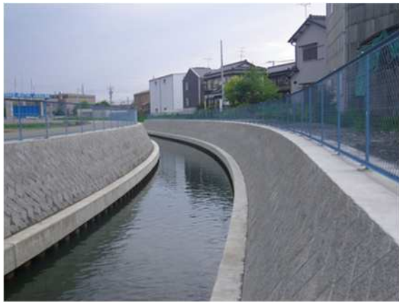
準用河川千間堀川改修(一宮市)
