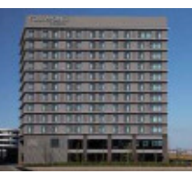
2 フォーポイントバイシェラトン名古屋 中部国際空港 Four Points by Sheraton Nagoya Chubu International Airport
