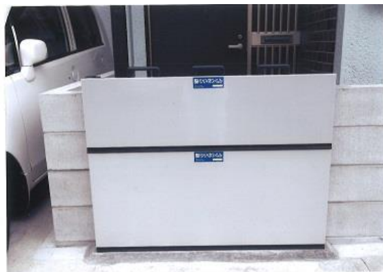
町内に設置された浸水防止塀
