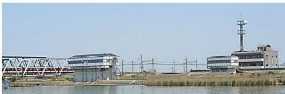
長良導水取水口（愛知県知多地域の水道水源として導水されている）
