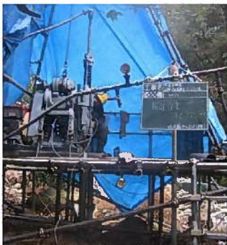
＜ボーリング調査＞
