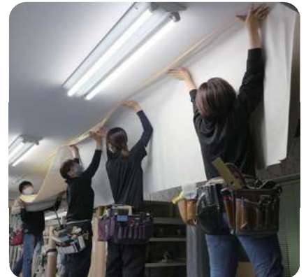
社員研修の様子（天井クロス貼り）
