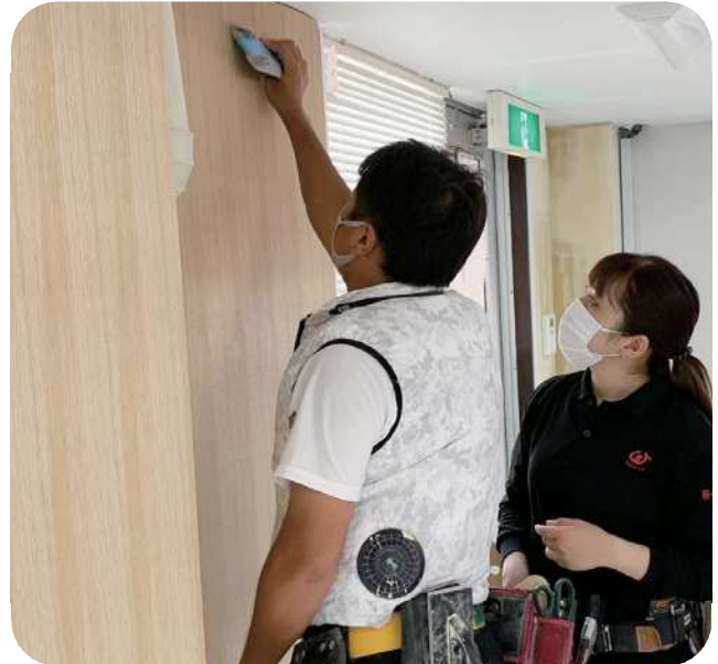
トレーニング用住宅での技能の伝承
