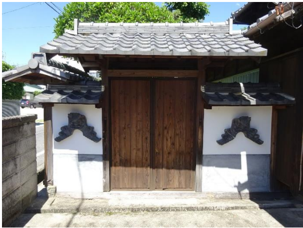
庭門及びび塀 庭門
