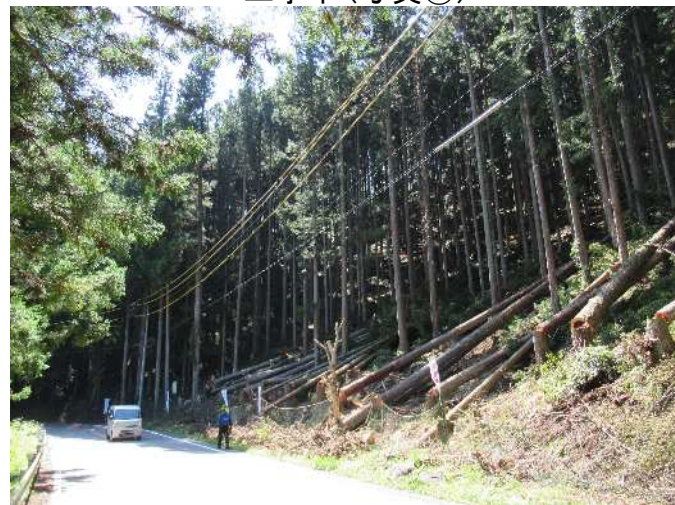
工事中(写真①)
