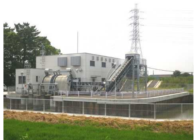
整備された排水機場
