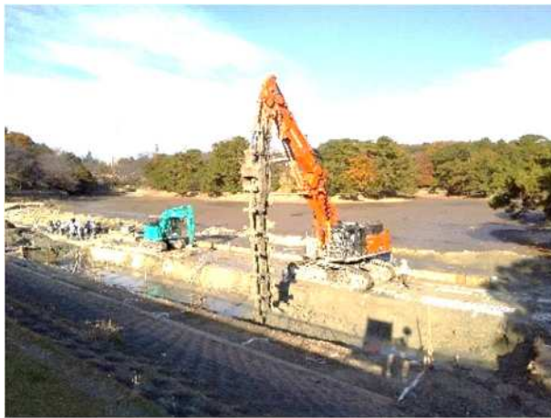
耐震化（地盤改良）されるため池
