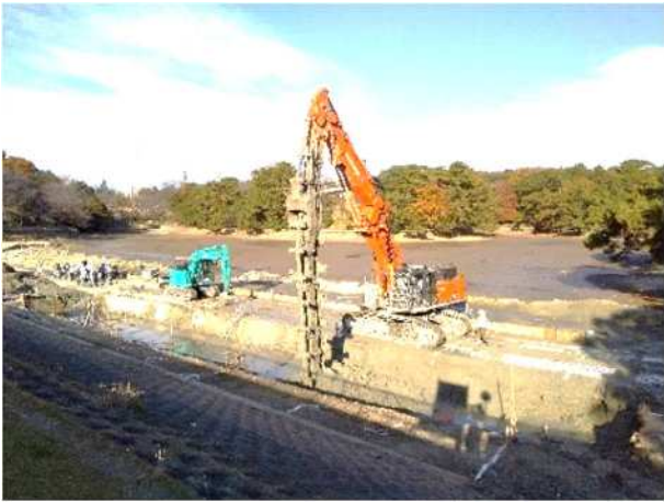
耐震化（地盤改良）されるため池
