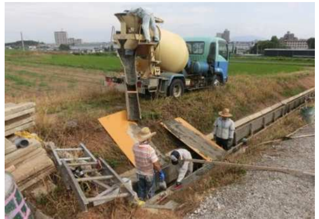
農業者や地域住民などによる排水路の補修
