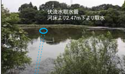
8月26日撮影 伏流水取水地点
