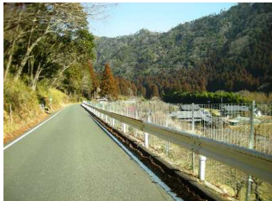
ワイヤーメッシュによる広域の侵入防止柵整備
