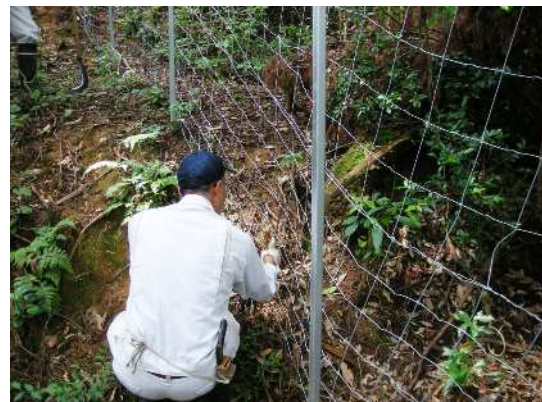
ちょっとした補修その場で実施
